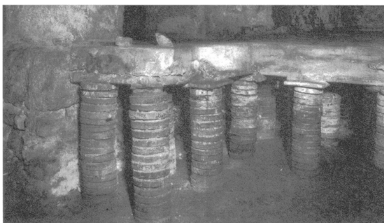
Starořímské Hypokaustum – použití kruhových cihel pro tvorbu spalinových dutin
