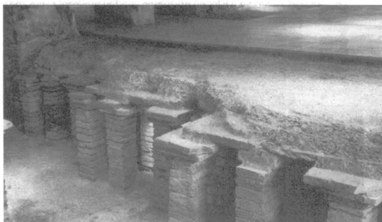
Obr. 2 Starořímské Hypokaustum – použití čtvercových cihel pro tvorbu spalinových dutin
