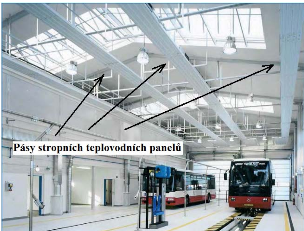
Obr. 20 Instalace sálových teplovodních panelových pásů do zkušební haly stanice technické kontroly.
