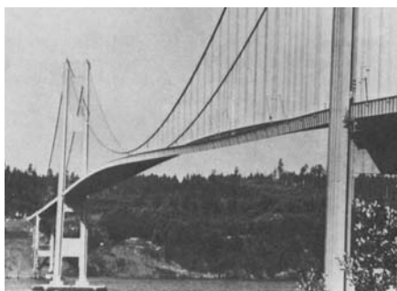
obr. 9.1 Tacoma Narrow Bridge při vichřici 7. listopadu 1940
